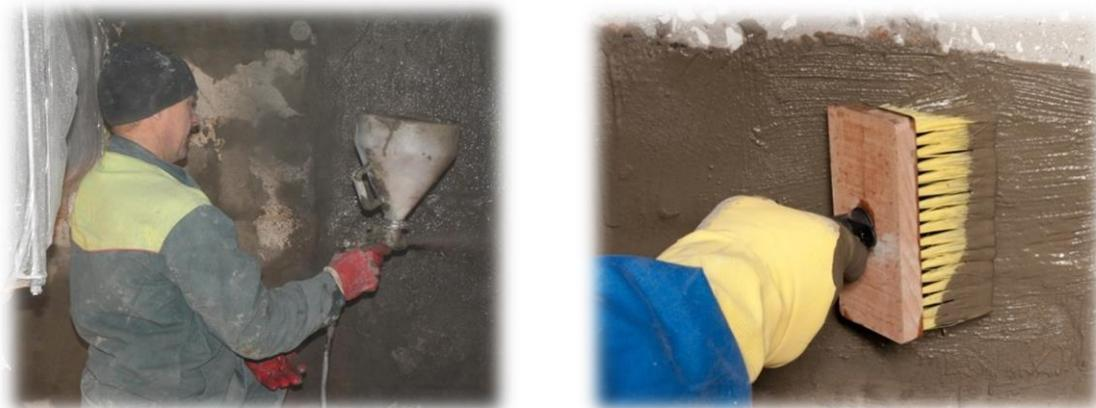
Рис. 8 – Нанесение состава КАЛЬМАТРОН-ЭЛАСТИК 2 варианта
