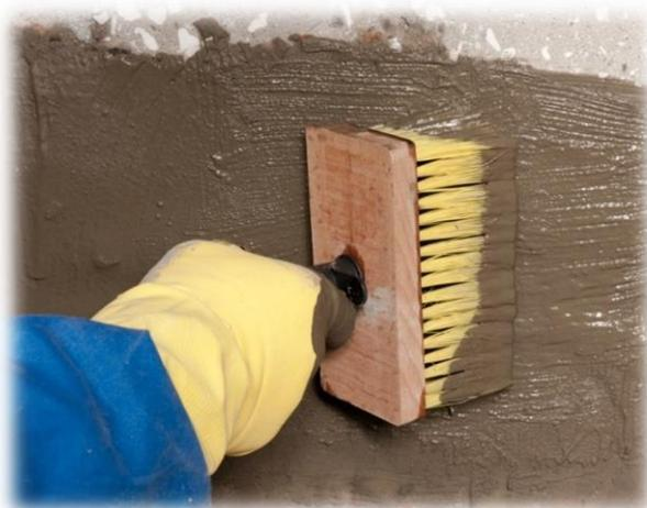
**Рис. 2 – Нанесение состава КАЛЬМАТРОН-АКРИЛАСТ кистью-макловицей**
