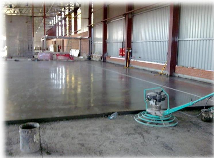
Рис. 7 – Бетонный пол после упрочненный топпингом
