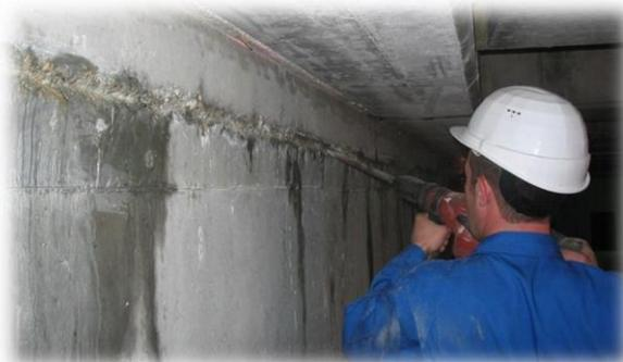
Рис. 3 Расшивка перфоратором «холодного шва бетонирования»
