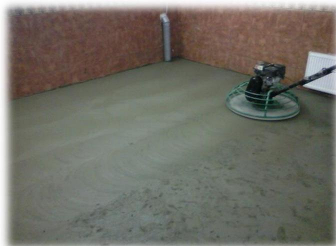
Рис. 6 – Шлифовка бетонного пола затирочной машиной
