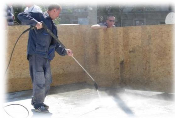
Рис. 11 – Очистение и увлажнение поверхности гидромонитором
