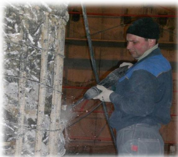
Рис. 10 – Удаление с поверхности поврежденного бетона
